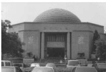
Průčelí pekingského planetária
