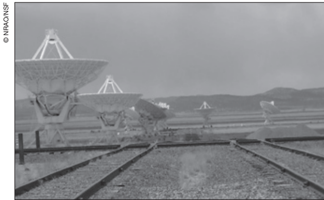
Sít' VLA. Antény jsou přepravovány po dvojitých kolejnicích a sestavovány do různých konfigurací.
