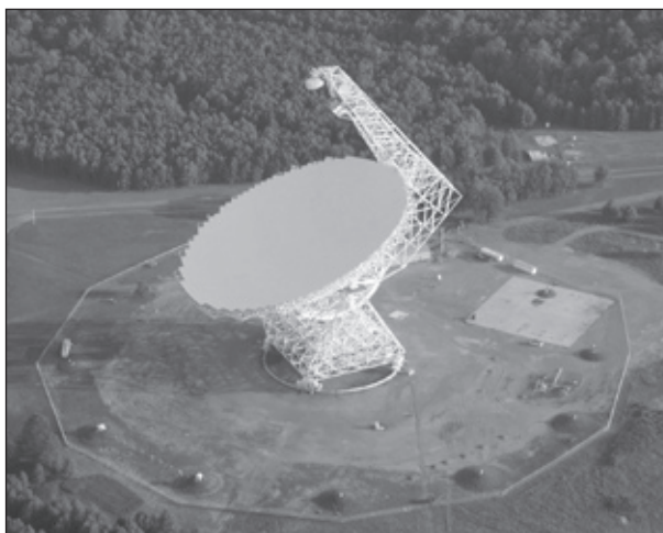
Současná podoba radioteleskopu Roberta Byrda v Green Banku. Parabola má 100×110 m, ohnisko je umístěno asymetricky. Na leteckém snímku je patrná kruhová kolejnice umožňující otáčení kolosu.
